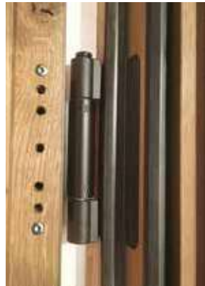
Einbausituation Standardband 3D-verstellbar
